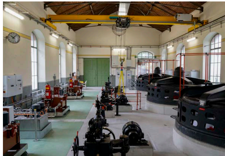
Maschinenhalle nach Abschluss der Bauarbeiten im September 2022
