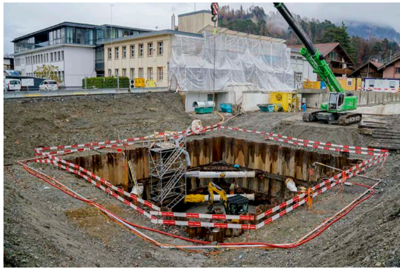
Sanierung des ersten Perimeters im November 2022
