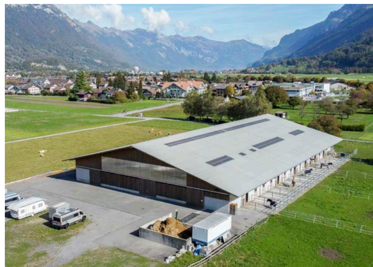
Das Pferdesportcenter Matten: Hier entsteht die erste Solargemeinschaft auf dem Bödéli. Die Anlage wird jährlich ca. 463 000 kWh Strom produzieren
