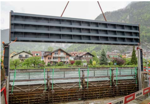
Montage des neuen Einlaufschützes im Mai 2021
