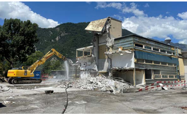
Abbruch erster Gebäude im Juni 2022
