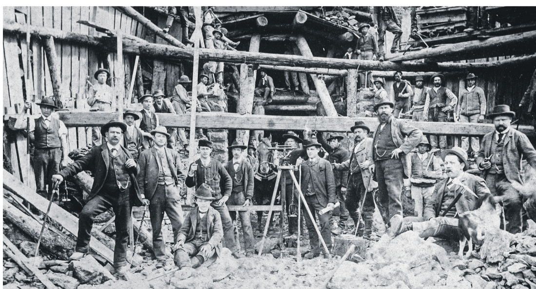
Der Bau des Reservoirs am Rugen war für die Pioniere ein denkwürdiger Meilenstein.
