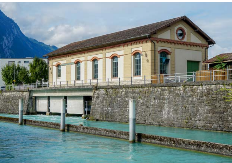
Im Jahr 2022 komplett erneuert: das IBI-Kraftwerk am Schifffahrtskanal
