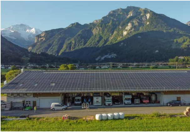
Die PV-Anlage auf dem Pferdesportcenter Matten liefert seit Ende Oktober 2023 Strom
