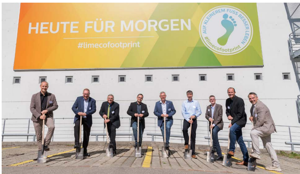
Partnerschaft mit Zukunft: IBI CTO Peter Heim (Zweiter v.r.) beim Spatenstich für die erste industrielle Power-to-Gas-Anlage der Schweiz
