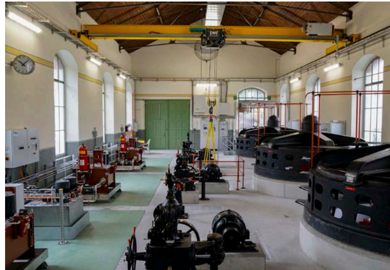
Maschinenhalle nach Abschluss der Bauarbeiten im September 2022
