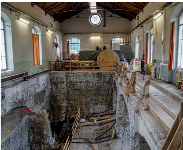
Maschinenhalle im Juli 2021
