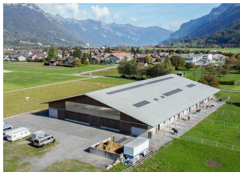
Das Pferdesportcenter Matten: Hier entsteht die erste Solargemeinschaft auf dem Bödéli. Die Anlage wird jährlich ca. 463 000 kWh Strom produzieren
